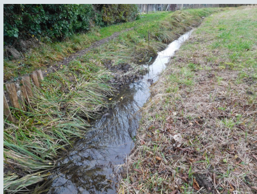
Canal à l'abandon
