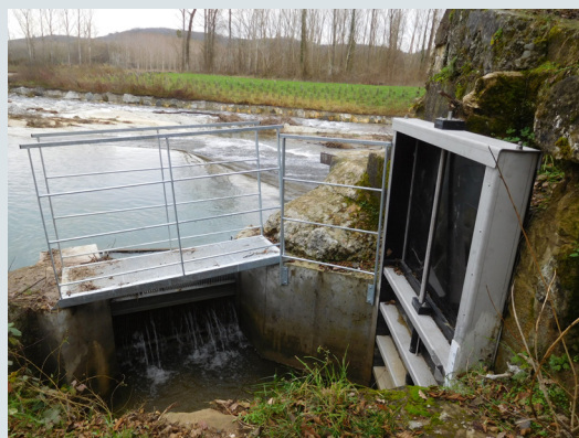
Nouvelle prise d'eau
